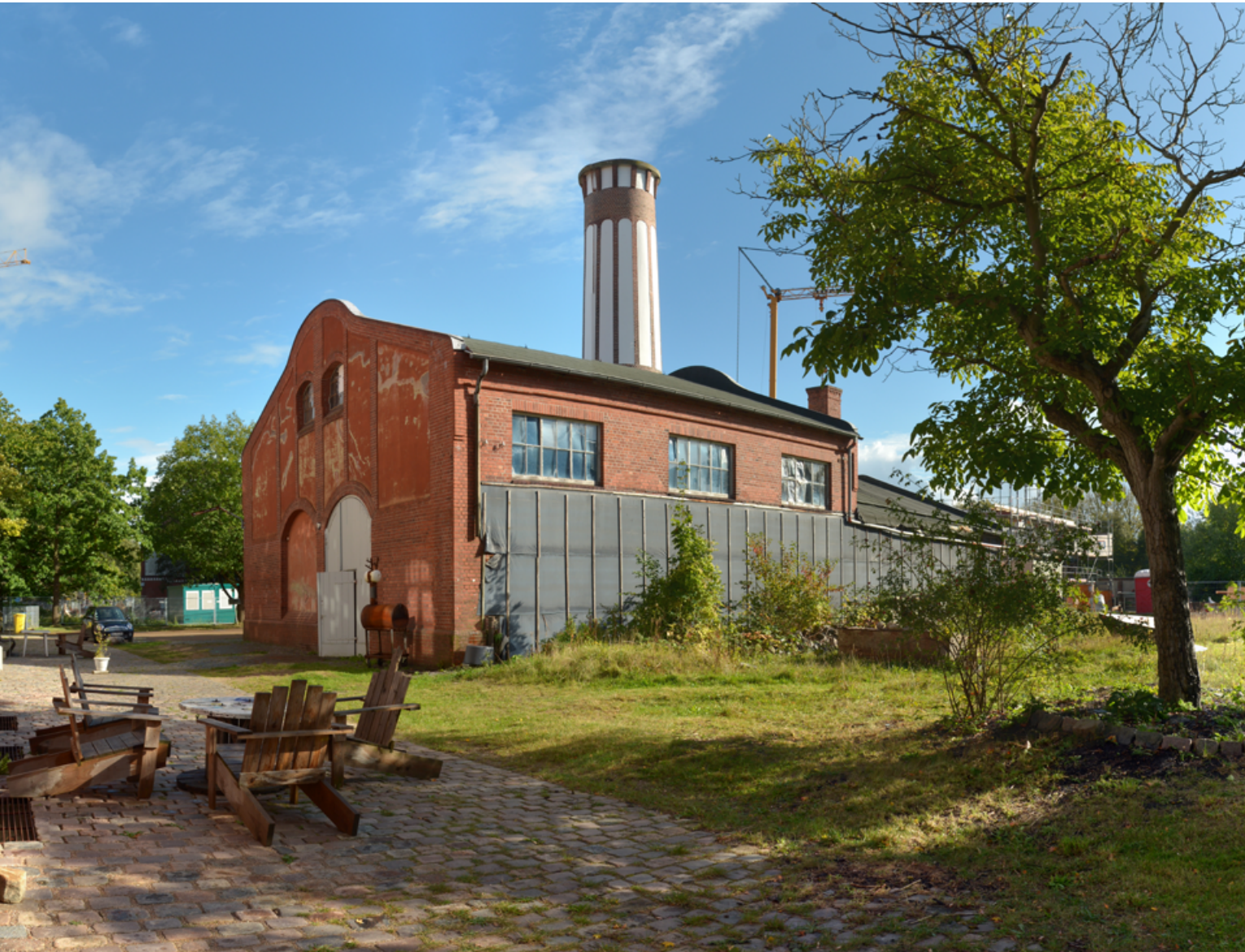
Abb.: Kesselhaus, Ansicht von Westen
